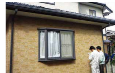
●外壁表面調查狀況
